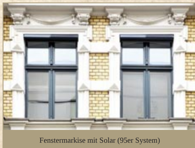
Außenansicht (7,3 cm Kasten, in die Laibung montiert)
