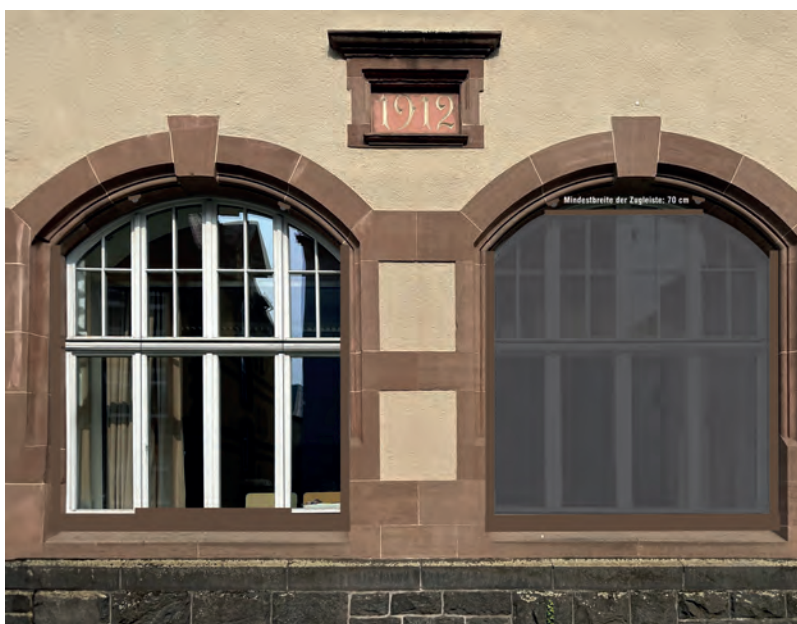
Modell mit Rundbogen: Die Zugleiste muss eine Mindestbreite von 70 cm haben.
